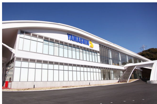
横須賀イノベーションセンター外観
